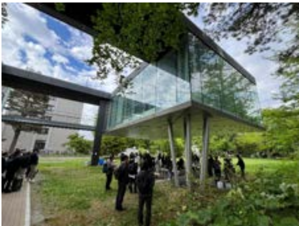
工学部共用実験棟
